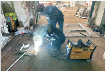
( 镇江电厂 ) 维修车间施工
