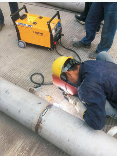
( 江阴热电厂 ) 管道焊接 ( 手工焊 )
