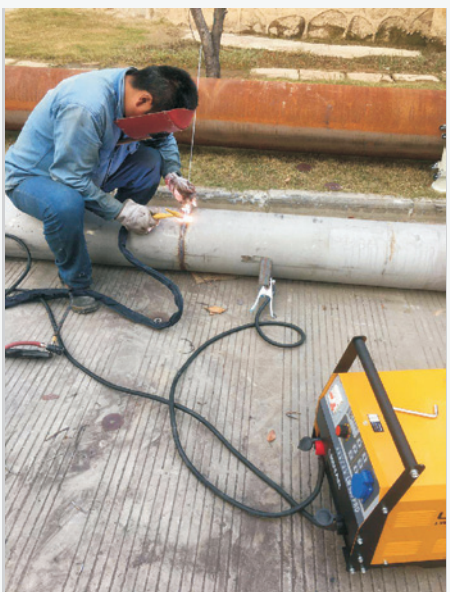
( 江阴热电厂 ) 管道焊接 ( 氩弧焊 )
