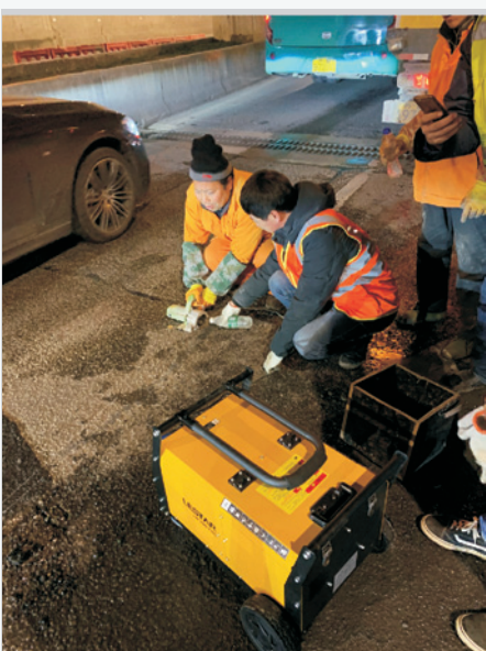
( 南京市政 ) 隧道施工
