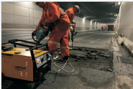
( 无锡市政 ) 隧道抢修(双电镐破碎)
